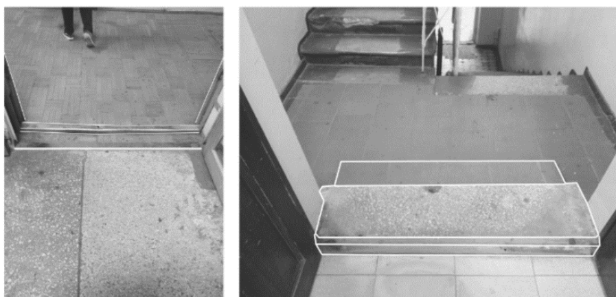
Рис. 4. Слева - пример высоты порога, соответствующего требованиям безбарьерной среды, справа - высота порога, препятствующая безбарьерной среде
