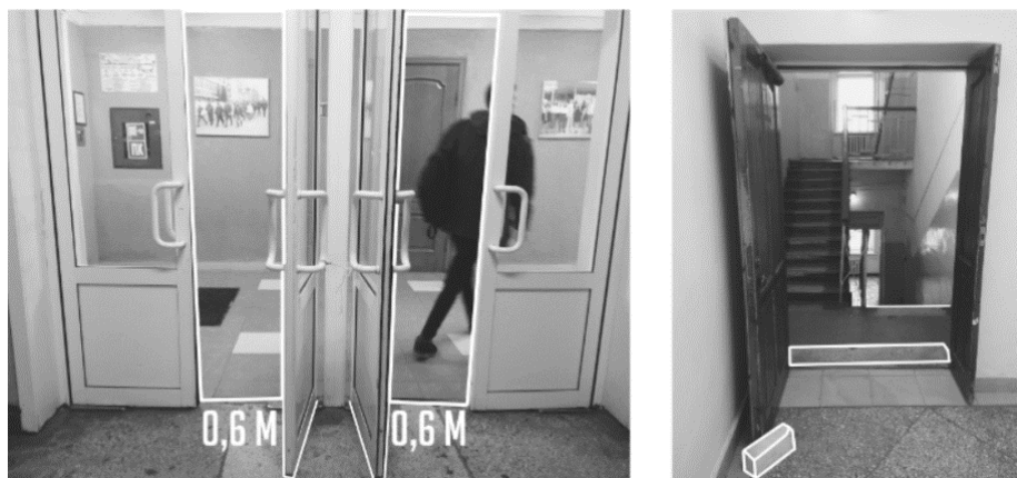
Рис. 2. Слева - пример установки дверного проема, препятствующий безбарьерной среды, справа – установка дверного проема, соответствующего требованиям безбарьерной среды
