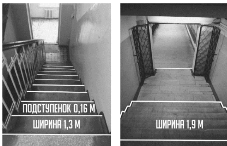
Рис. 3. Слева - пример ширины движения, препятствующий безбарьерной среды, справа – ширины движения, соответствующего требованиям безбарьерной среды
